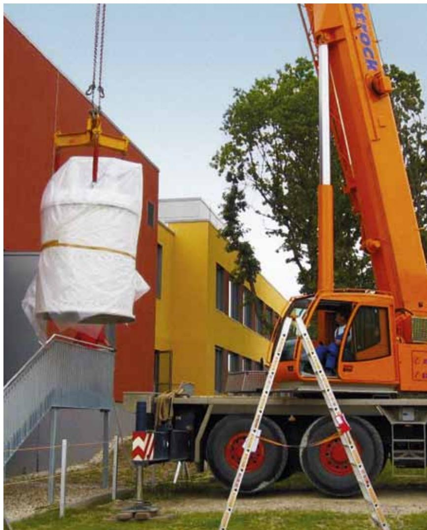
Der vier Tonnen schwere und fast fünf Meter hohe Magnet des 800 MHz Spektrometers wird mit einem Kranwagen in die neue NMR-Halle gehoben.
