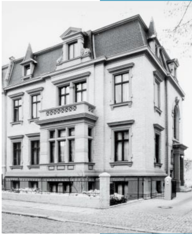
In diesem Gebäude – Reichardtstraße 9 – befanden sich die Geschäftsstellen der drei Personalkommissionen
